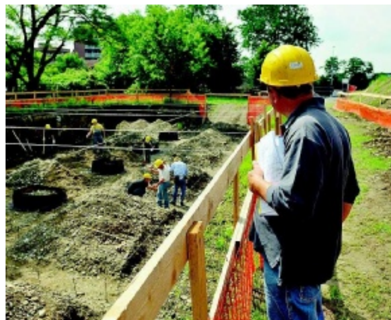
VIGILE Il capocantiere controlla il lavoro dei suoi «carpentieri» (Spf)
